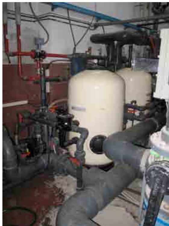
Foto 3: in genere la filtrazione dell'acqua di una piscina avviene in grandi filtri.
