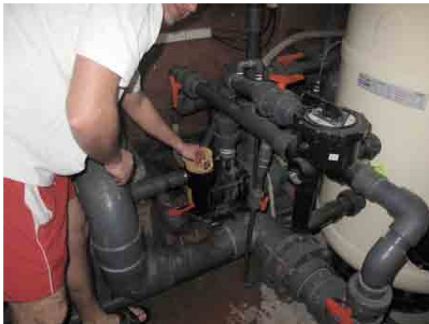
Foto 4: a monte del filtro e della pompa si trova un prefiltro che trattiene le impurità più grossolane.
